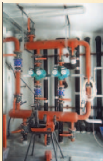
Scorcio Centrale termica in costruzione Hotel Eden Brienza (Pz)
