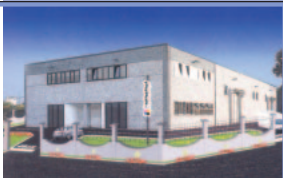
Nuovo stabilimento di produzione
