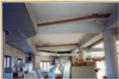
Condotte Aerauliche - Hotel Eden Brienza (Pz)
