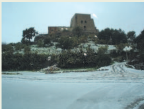
VISTA TORRE TALAO LATO INGRESSO
