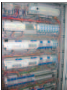
Quadro elettrico Automazione domotica
