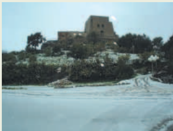
VISTA TORRE TALAO LATO INGRESSO
