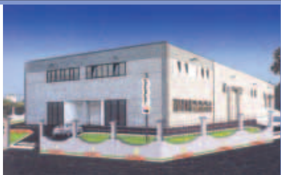
Nuovo stabilimento di produzione
