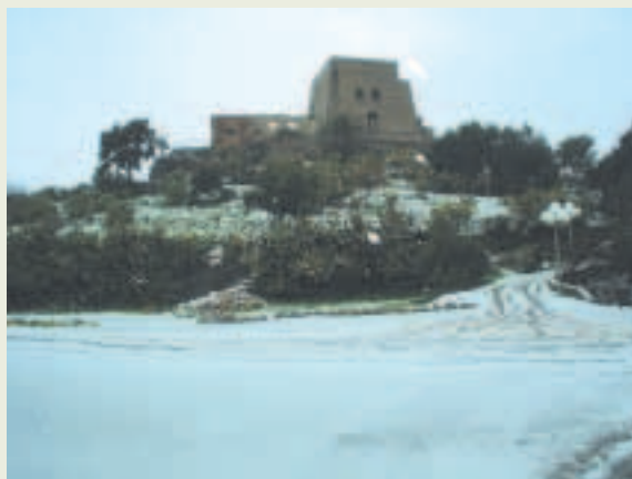
VISTA TORRE TALAO LATO INGRESSO
