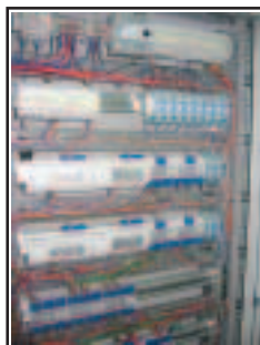
Quadro elettrico Automazione domotica
