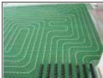
Impianto di riscaldamento a pannelli radianti
