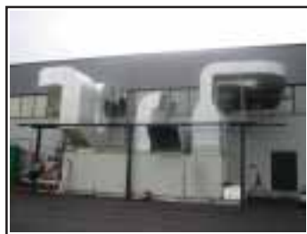
Unita' di trattamento aria
