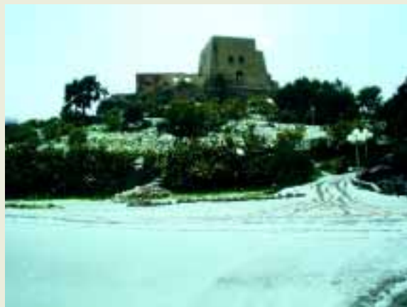
VISTA TORRE TALAO LATO INGRESSO
