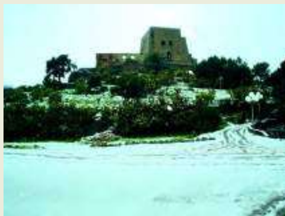
VISTA TORRE TALAO LATO INGRESSO
