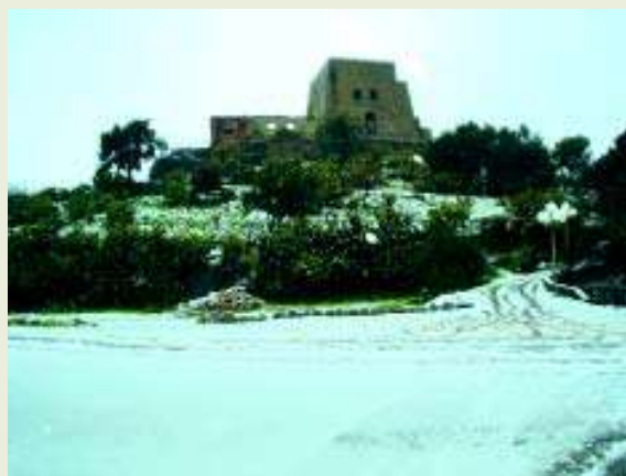
VISTA TORRE TALAO LATO INGRESSO
